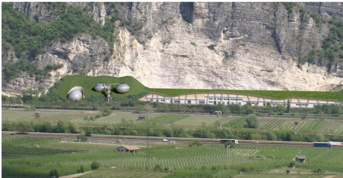
Figura 1-4: immagine che rappresenta il depuratore con soluzione denominata sottomonte, completamente esterno alla montagna.
