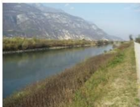
Foto 2.8.5.2 – Manutenzione meccanica lungo gli argini
