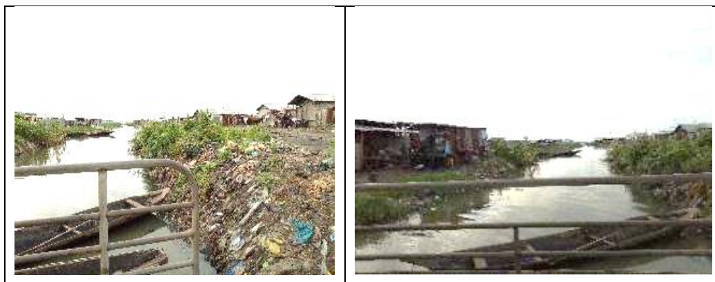
Planche 13 : Déchets aux abords de l'ouvrage Qc
