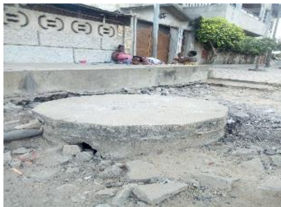
Photo 51 : Puisard dans la rue 369, sous bassin Pb, quartier Zogbohouè
