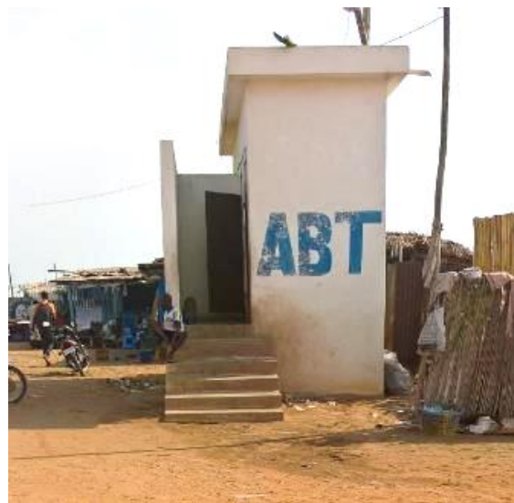
Photo 40: Latrines publiques dans le 1 er arrondissement, Rue 1.14 dans l'emprise collecteur ZB4
