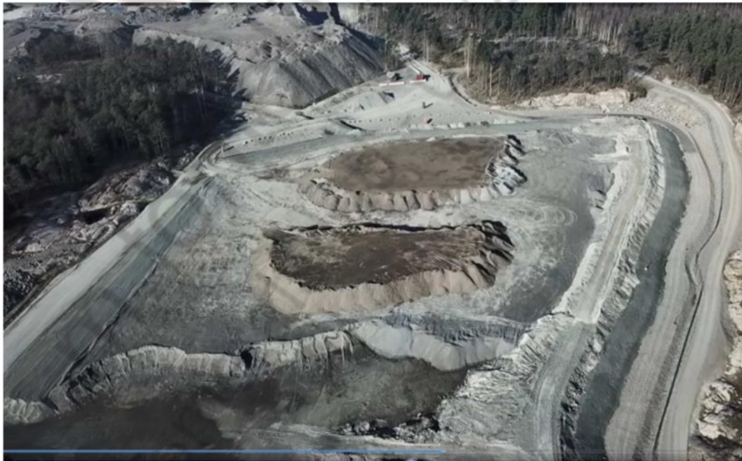
Figure 6.5-3. Slag stockpile (465 000 t) in Oxelösund.
