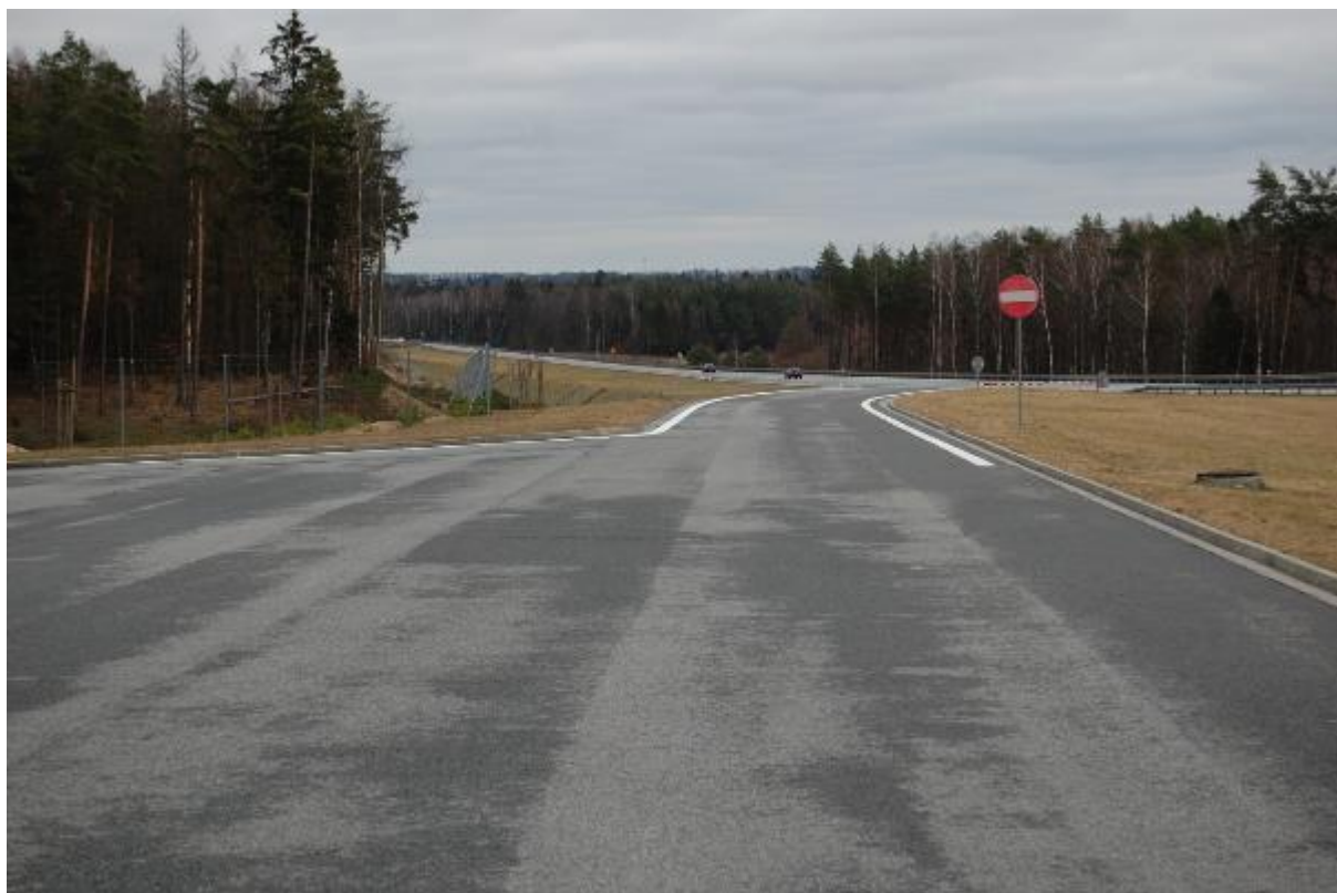
Zdjęcie 8 Obwodnica na Odcinku 2 – miejsce na MOP (około km 3+000 C: 9+180)
