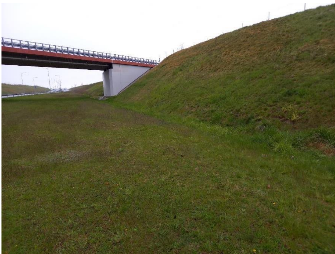
Zdjęcie 11 Rezerwa terenu pod drugą jezdnię
