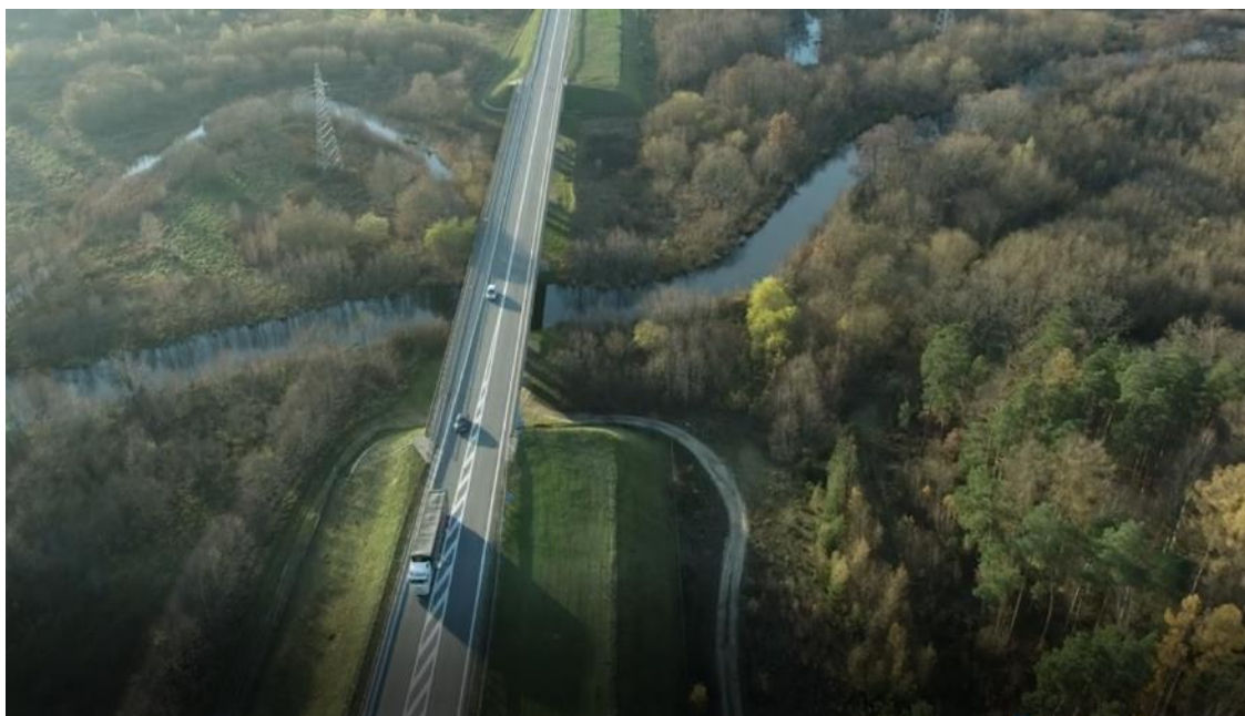
Zdjęcie 7 Przejście istniejącej jezdni nad rzeką Słupią
