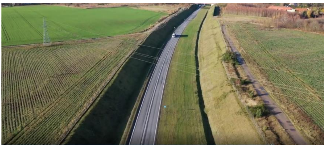
Zdjęcie 5 Przejście linii napowietrznej nad drogą
