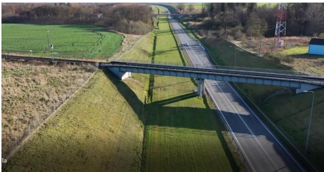
Zdjęcie 3 Wiadukt kolejowy nad projektowaną obwodnicą Słupska
