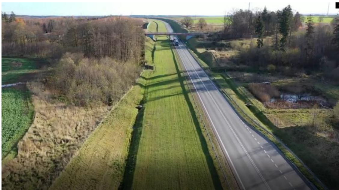
Zdjęcie 4 Zbiornik retencyjny po prawej stronie pierwszej jezdni obwodnicy Słupska
