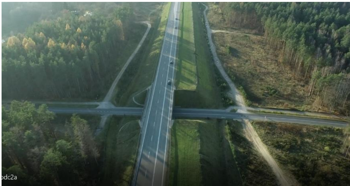
Zdjęcie 6 Przejście istniejącej jezdni nad drogą dojazdową
