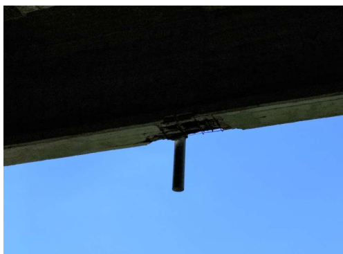
Figura 5-2. Ammaloramento trave di bordo esterna T4 ed interna T1
