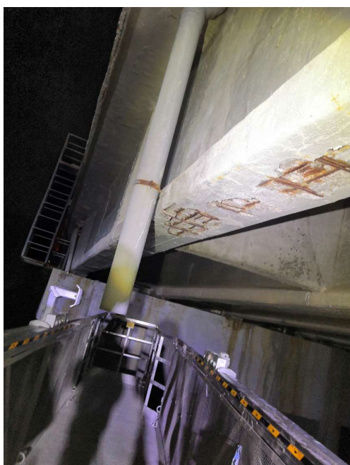
Figura 5-3. Ammaloramento trave di bordo esterna T4
