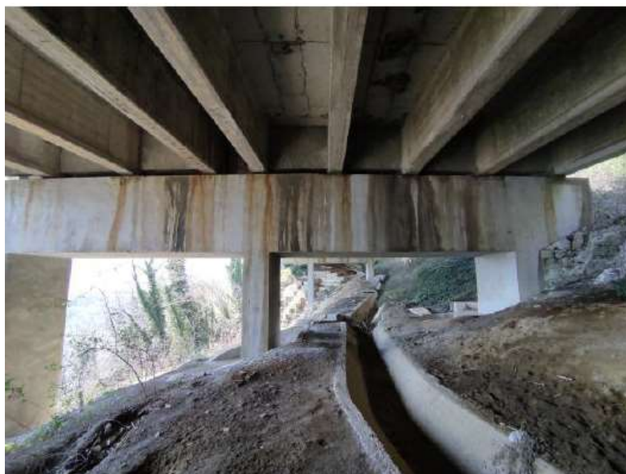
Figura 3-3. Dettaglio impalcato – travi in C.A.P e pile
