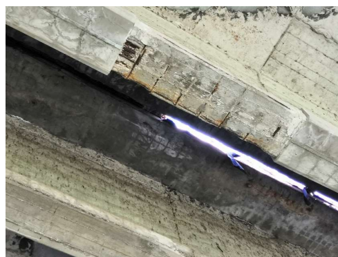
Figura 5-2. Ammaloramento trave di bordo esterna T4 ed interna T1
