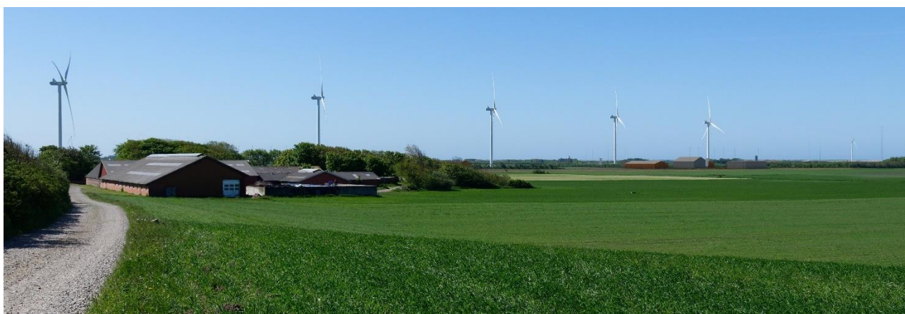
Figur 18-14 Fotostandpunkt 5 – Visualisering. Stationsanlæggene vil være synlige fra dette punkt, indtil den afskærmende beplantning er vokset op i fuld højde.
