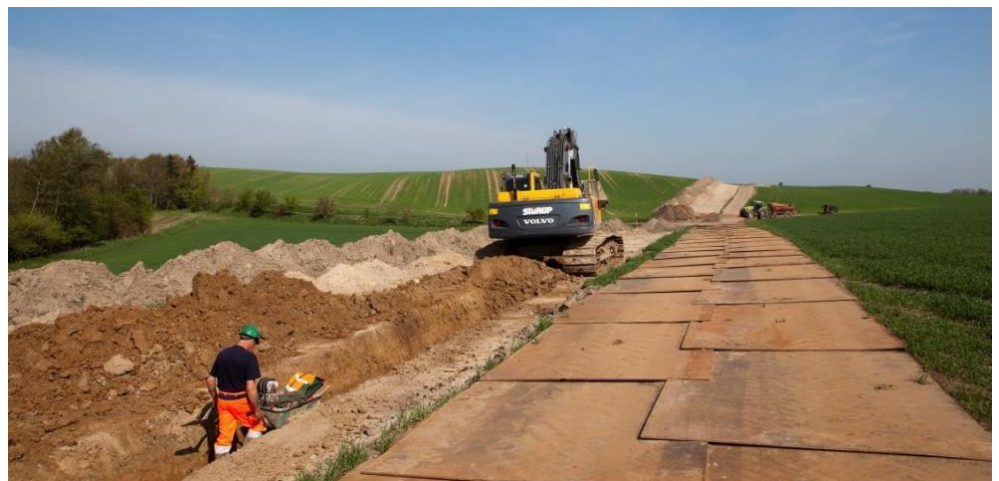
Figur 2-3 Eksempel på arbejdsbælte med afrømmet rå- og muldjord samt køreplader. På billedet ses et kabeltracé med ét kabelanlæg, mens der i projektet etableres to eller tre kabelanlæg ved siden af hinanden på strækningen kysten Volder Mark og to kabelanlæg på strækningen Volder Mark-Idomlund.
