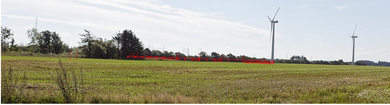
Figur 18-33 Fotopunkt I – Eksisterende forhold set fra Idomlundvej, nær nr. 5. Det nye stationsanlægs konturer er markeret med rød streg.
