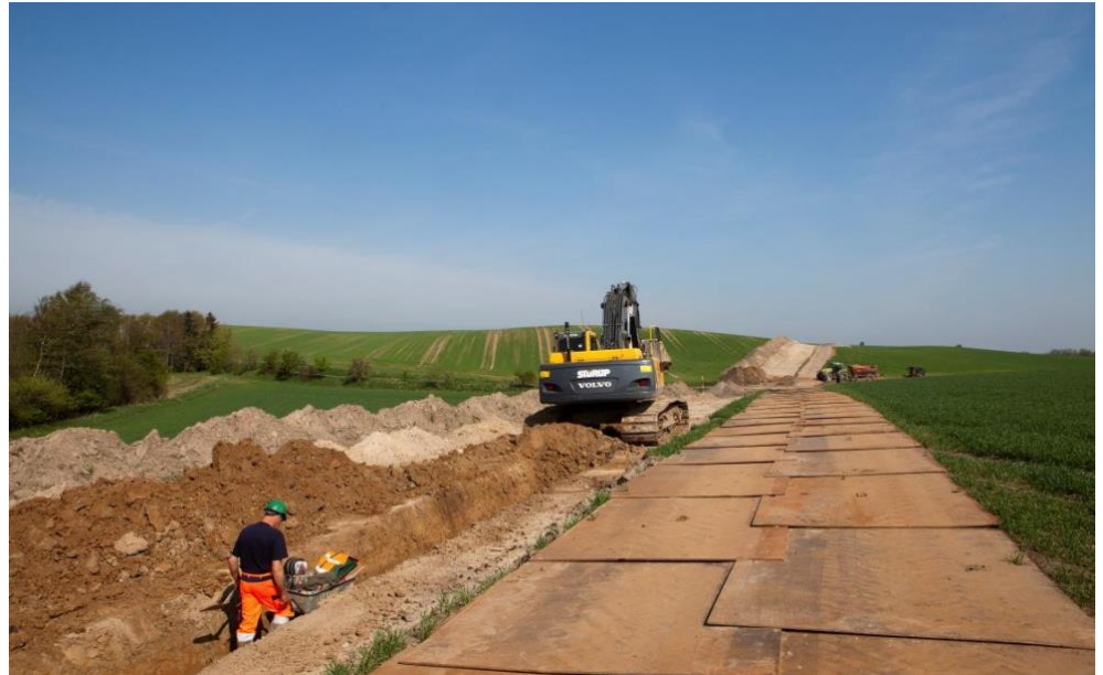
Figur 4-7: Eksempel på arbejdsbælte med afrømmet rå- og muldjord samt køreplader. På billedet ses et kabeltracé med ét kabelanlæg.
