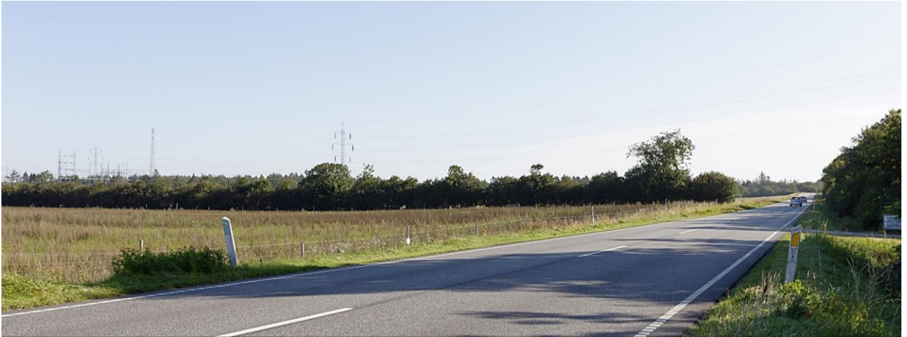
Figur 18-21 Fotostandpunkt 1 – Eksisterende forhold set fra Ringkøbingvej vest for højspændingsstationsområdet.
