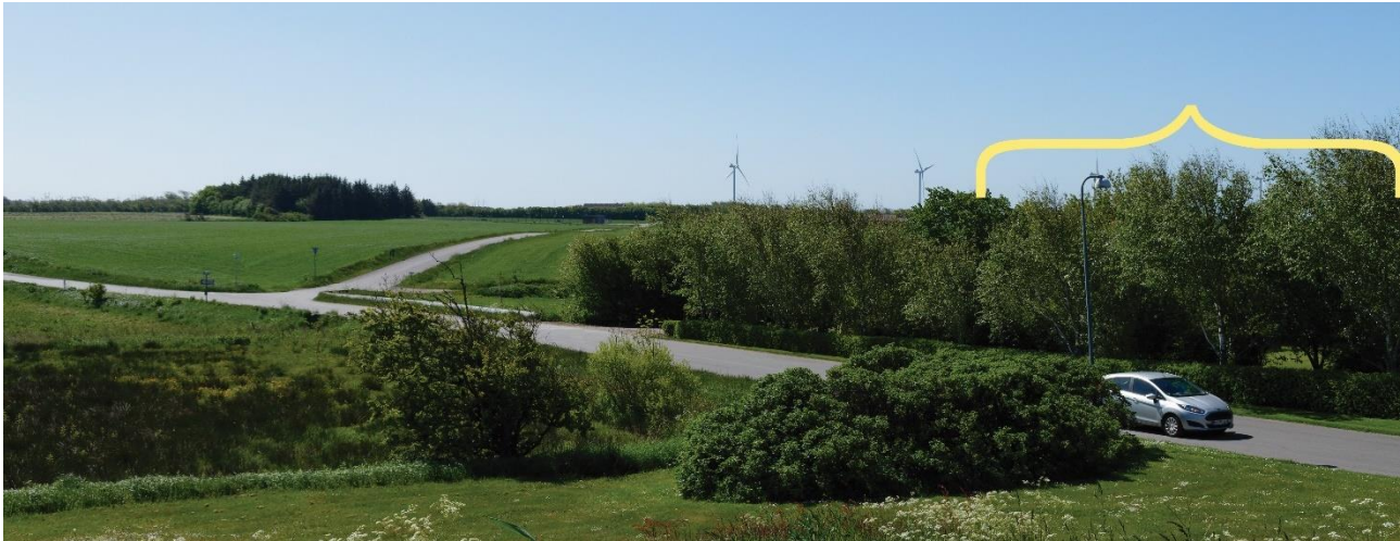
Figur 18-16 Fotopunkt: Ramme. Udsigt fra Ramme Kirke til højspændingsstationsområdet. Det vil ikke være muligt at se stationsanlæggenes på grund af terrænvariationen og afstanden. Afstand til stationsanlæggenes er ca. 2,7 km. Stationsanlæggenes omtrentlige placering og udbredelse er vist med gul klamme.
