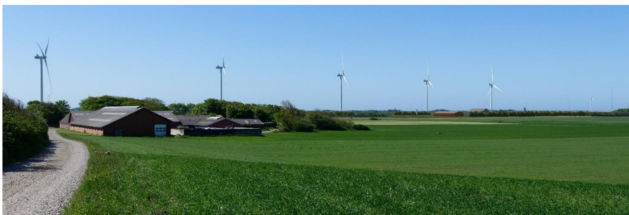
Figur 18-15 Fotostandpunkt 5 – Visualisering med ny beplantning. Stationsanlæggenes synlighed begrænses af den afskærmende beplantning.
