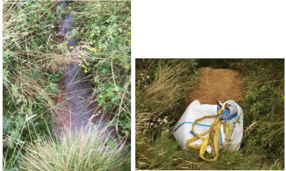
Figur 4-11 I forbindelse med Energinets projekt, Horns Rev 3, hvor et kabelanlæg blev nedgravet i 2015, skete der et blow-out ved en bæk. Her blev der anvendt bigbags med sand til inddæmning.
