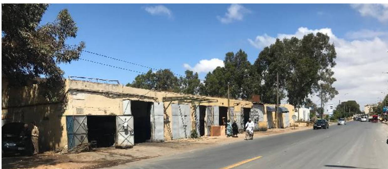
Figure 2 : Commerces à démolir entièrement à l'avenue Zarbia
