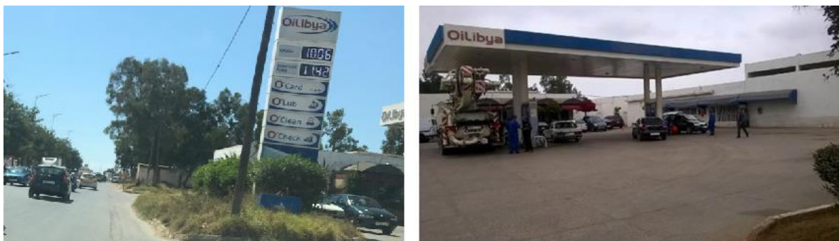
Figure 3 : Station-service à démolir à l'avenue Zarbia
