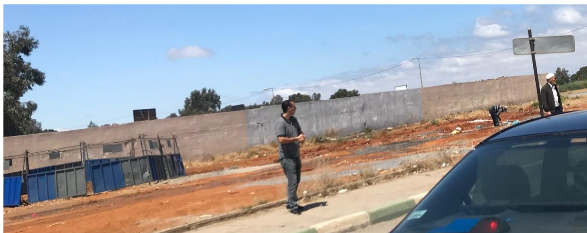
Figure 4 : Photo du nouveau mur reconstruit à la nouvelle limite d'emprise de la parcelle T53372/R
