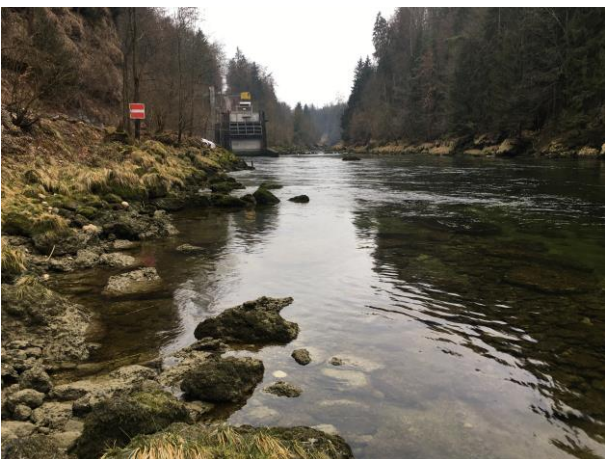
Abbildung 2.1-6 KW Traunfall Kraftwerk
