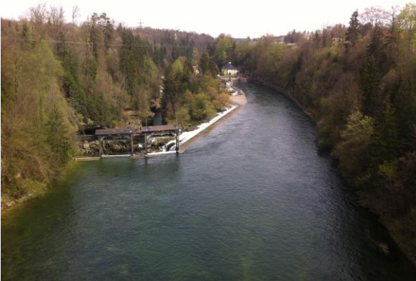
Abbildung 2.1-4 KW Traunfall Wehranlage
