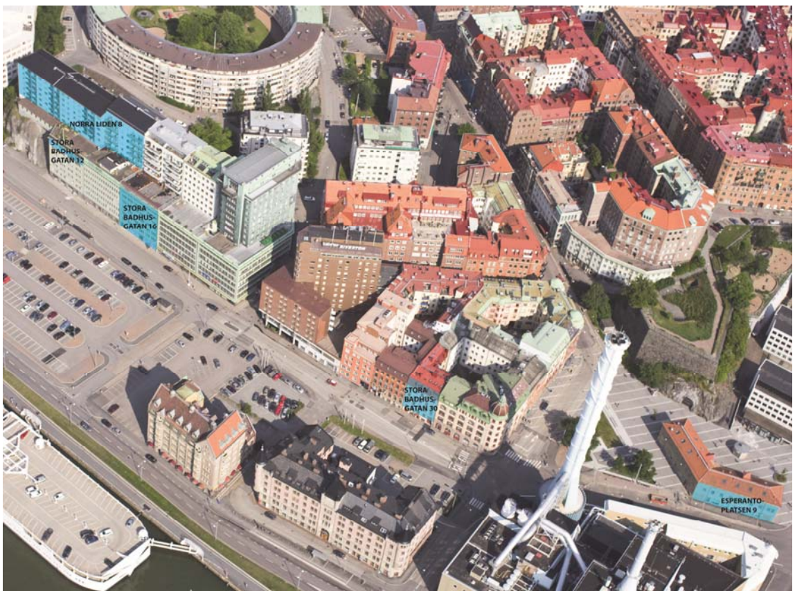
De västra fasaderna som är aktuella för eventuella åtgärder enl. listan på föregående sida
