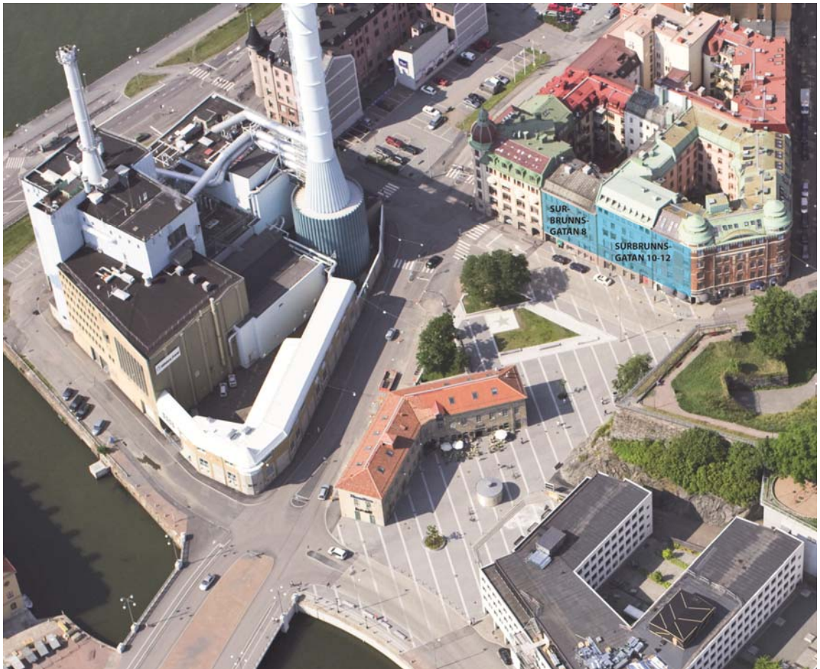
De södra fasaderna som är aktuella för eventuella åtgärder enl. listan på föregående sida
