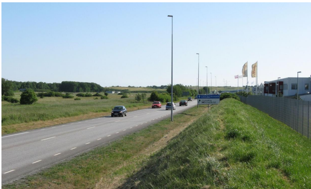
3.1:1 På den f d landningsbanan ligger idag både väg 155 och ett verksamhetsområde
