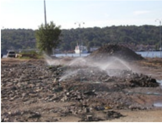
En situsanering med hjälp av bakterier
