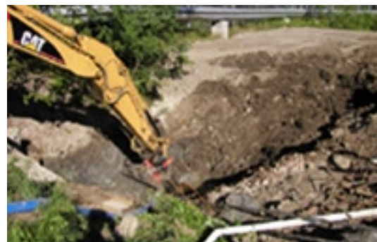
Schaktning av förorenad mark
