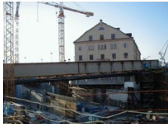
Exempel på djupt schakt under byggtiden, från Rosenlunds-kanalen i Göteborg
