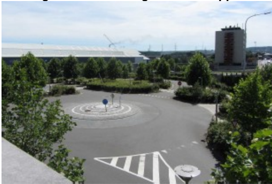
Aménagements récents gare de Jemeppe.
