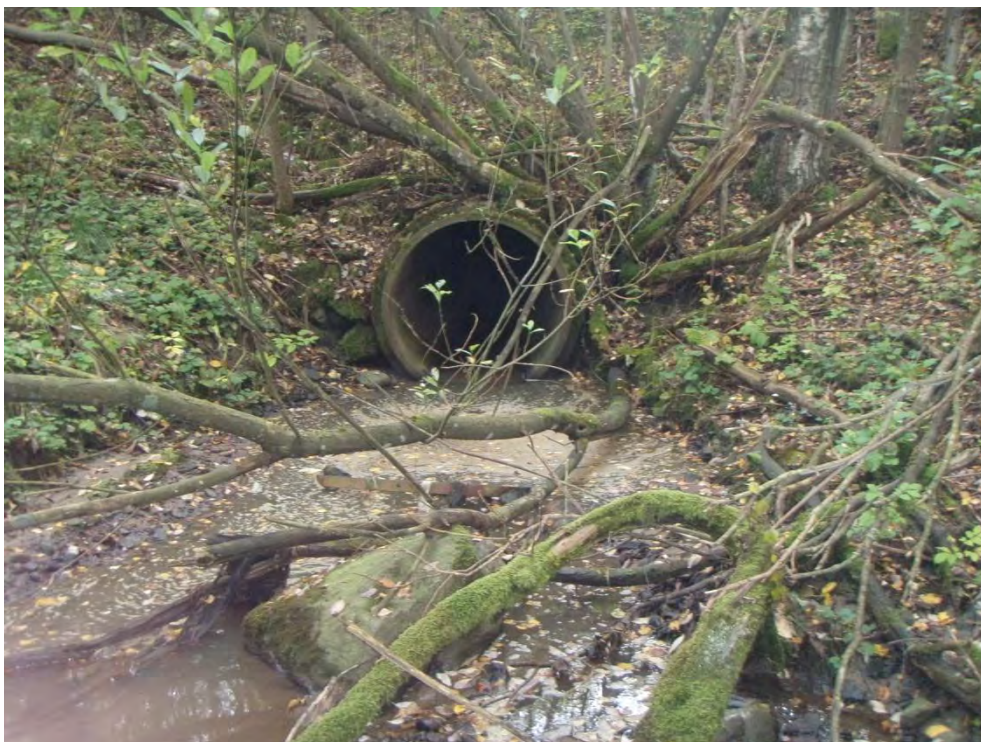
Bild 6. Utlopp ur trumma under väg 190.
