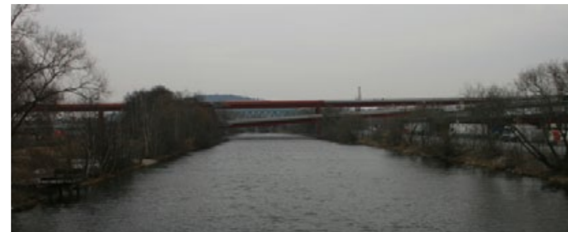
Bild 24. Strandzon med värdefull trädbård nedströms järnvägsbron och Partihallsbroarna
