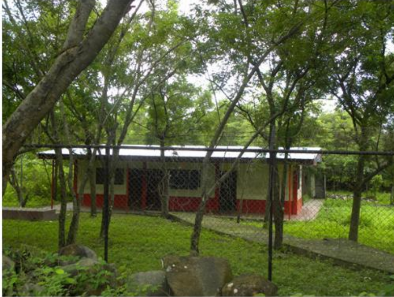
Foto No. 36 Centro de salud en la comarca Cenicera sur. Comarca Santa Lucía. Municipio El Sauce
