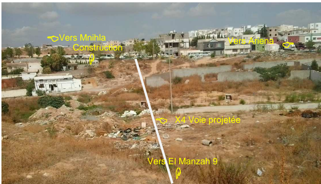
Construction côté du Jardin d'El Manzah 2
