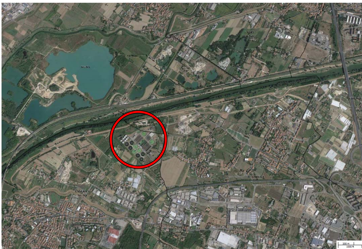
Figure 2-1 – Foto Aerea con ubicazione impianto San Colombano
