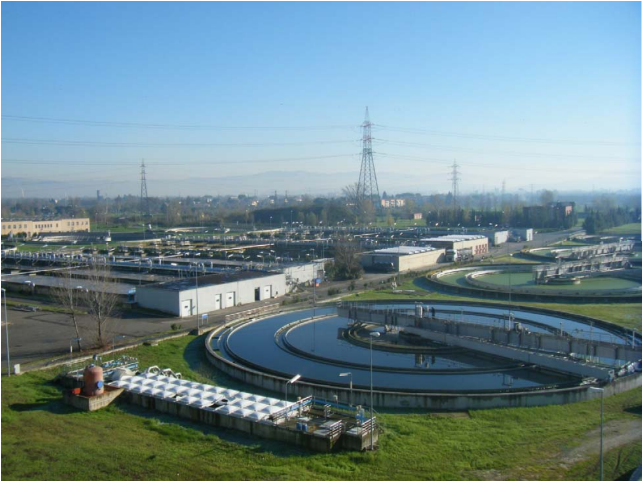
Figure 3-3 - Foto scattata in direzione Nord-Est dalla sommità dei digestori anaerobici
