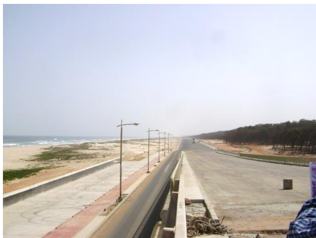
Photo 15 : Axe VDN prolongée sur la corniche
