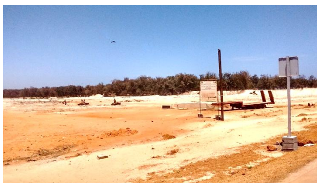
Photo 17 : Autre facette du site du dépôt BRT: Gadaye
