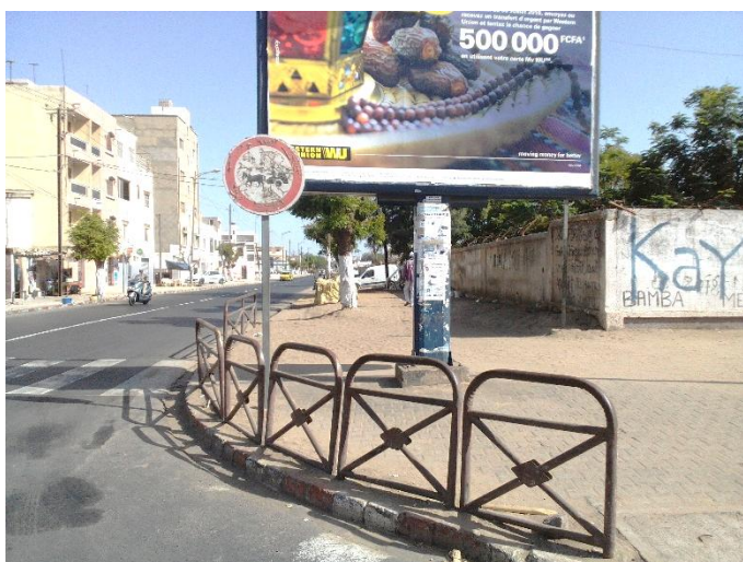
Photo 10 : Mur du Lycée Kennedy impacté
