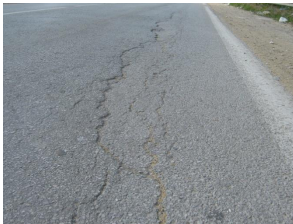
Photo 9 : Fissures longitudinales
