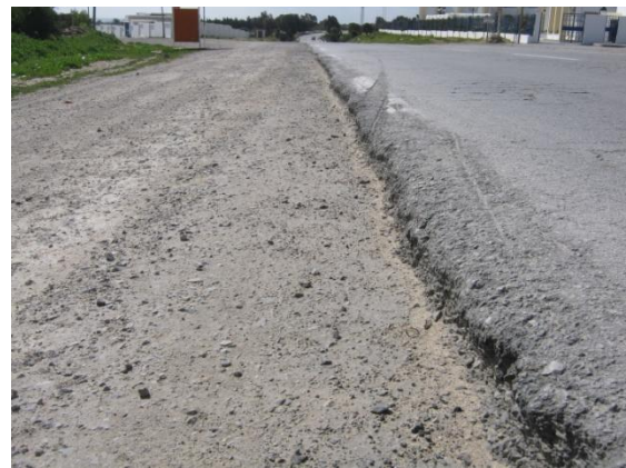
Photo 10 : accotement en contre-bas par rapport à la chaussée existante
