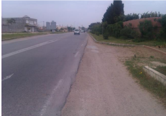
Photo 3 : Accotement en contrebas par rapport à la chaussée
