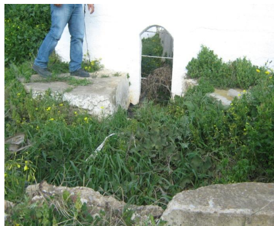
Photo 10 : OH au PK 77+635 (amont)
