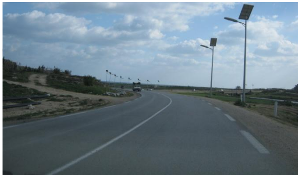
Photo 4 : chaussée existante en bon état
