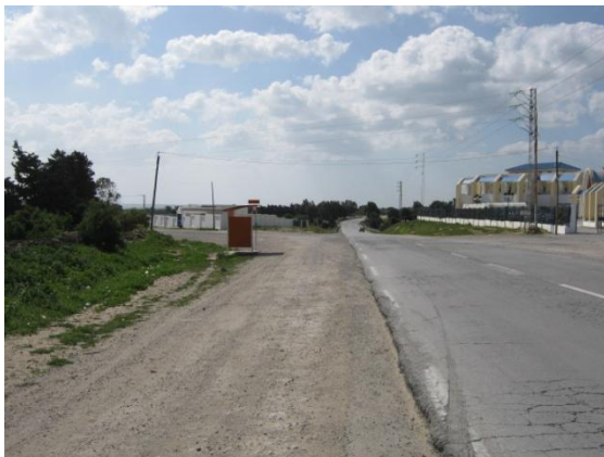
Photo 10 : accotement en contre-bas par rapport à la chaussée existante
