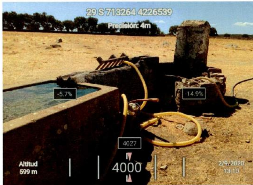
1º Pozo artesano (con agua pese a la sequía) y pila. Pol 4 Parc 78. Posibilidad bombeo solar para bebedero de aves y para anfibios como compensación.
