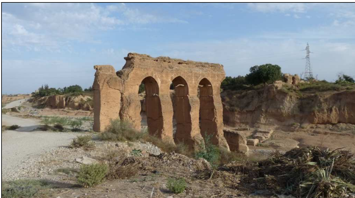
Figure 11 : Aqueduc de l'oued Louaar
